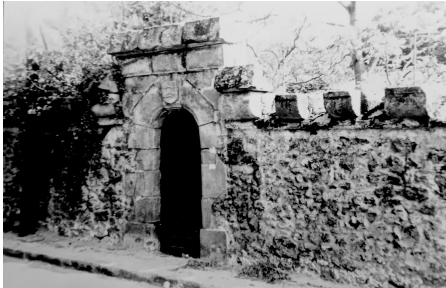
Porte sur le tracé de la muraille primitive, avant son démontage et son déplacement lors de la construction de l'école maternelle vers 1981.
