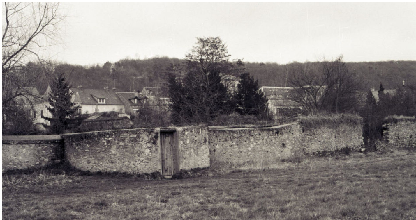
État de la muraille sud en 1979 avant l'aménagement du parc et du parking © Dehan 1979
