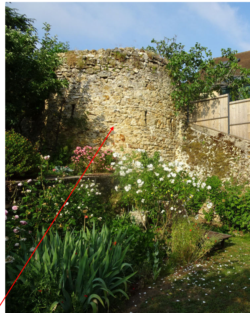
Vue De la tour nord-ouest entretenue par les propriétaires privés, Elle est invisible depuis l'espace public © Dehan 2023
